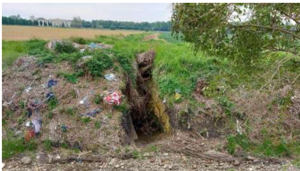
Figura 4 – tubazione di immissione di una roggia in sponda sinistra, con importante erosione, senza flusso di acqua
