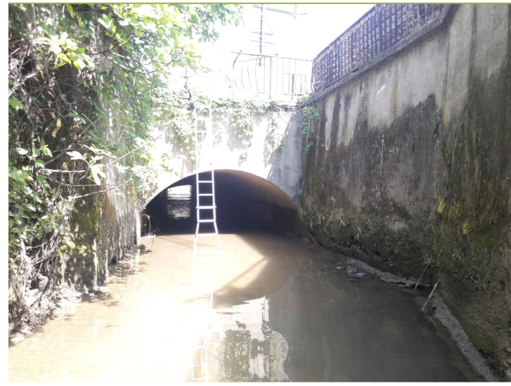
1 - MURO CON FRATTURA ALLA BASE O EROSO
