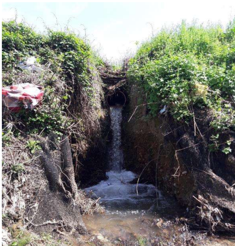
Figura 3 – tubazione di immissione di una roggia in sponda sinistra, con importante erosione. Nella foto si vede il geotessile presente sulle sponde (foto verso la sponda sinistra)
