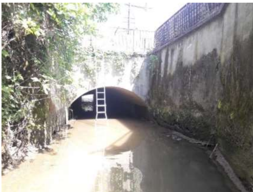
Figura 7 – muro in sponda sx in calcestruzzo eroso (foto verso monte)
