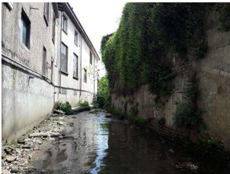
Figura 17: tubazione in acciaio in sponda sinistra (probabile utenza gas)
