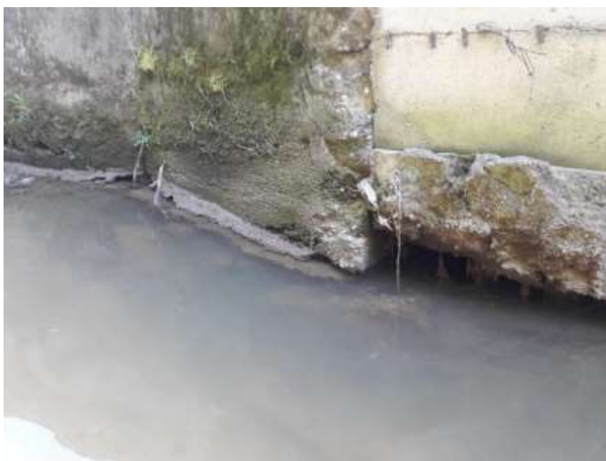
Figura 8 – muro in sponda sx in calcestruzzo da sottomurare (foto verso monte)
