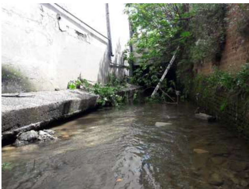
Figura 9 – muro in sponda sx con protezione al piede scalzata (foto verso valle)
