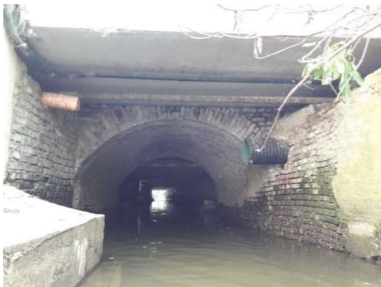
Figura 19: tubazione in acciaio in sponda sinistra (probabile utenza gas)
