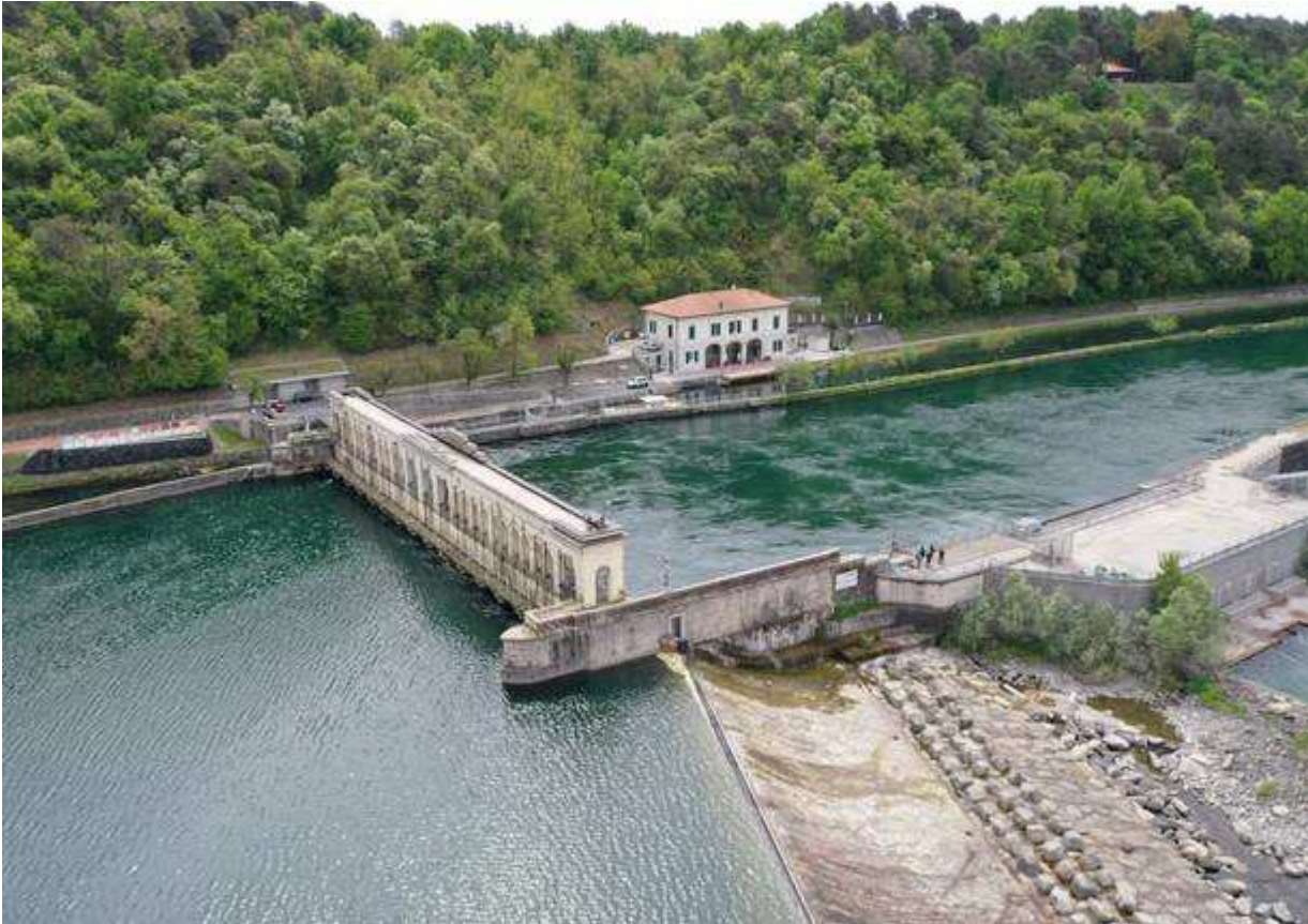
L'opera di presa del Panperduto, dove vengono derivate dal Ticino le acque del Canale Industriale e del Villoresi
