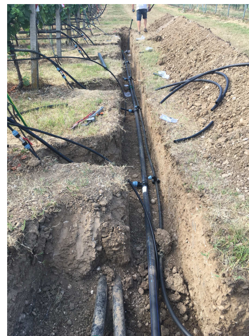
Tubazione di testata con elettrovalvole
