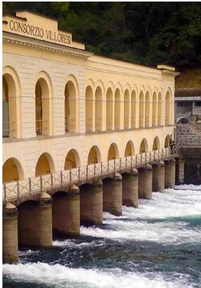
Anche l'edificio dell'opera di presa a Panperduto contribuisce alla produzione di energia idroelettrica turbinando la massa d'acqua che deve essere rilasciata al Fiume Ticino. Per questo nel 2015 proprio qui è stata costruita la centrale idroelettrica di Panperduto, realizzata da EGPV Srl (società composta da Enel Green Power e Consorzio Est Ticino Villoresi) nello spallone nord-ovest del bacino di calma.
