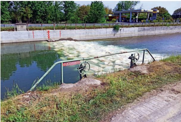
sponda del canale. Le cosiddette 'ture provvisorie' (realizzate dopo la siccità del 2022 per garantire l'irrigazione a circa 90.000 ettari di colture per lo più risicole) sono state provvidenziali anche in momenti di non particolare criticità idrica, come quelli dello scorso agosto, quando la riduzione di portata derivata dal lago è intervenuta in una fase colturale delicata, considerata la semina tardiva causata dalle abbondanti piogge.
