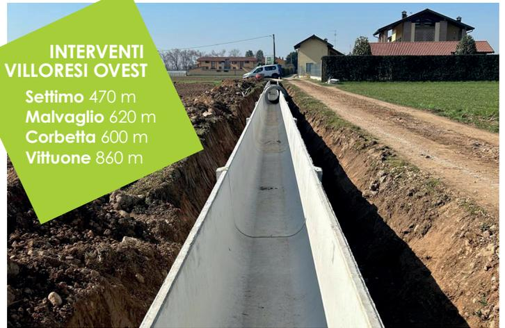
In particolare gli interventi riguardano i lavori di manutenzione e consolidamento sui canali diramatori di Arluno (diramatore 4: rifacimento del rivestimento per 600 m), di Settimo (diramatore 3: lavori sul ponte canale) e di Cuggiono (diramatore 5: rifacimento e posa canalette per 400 m).
