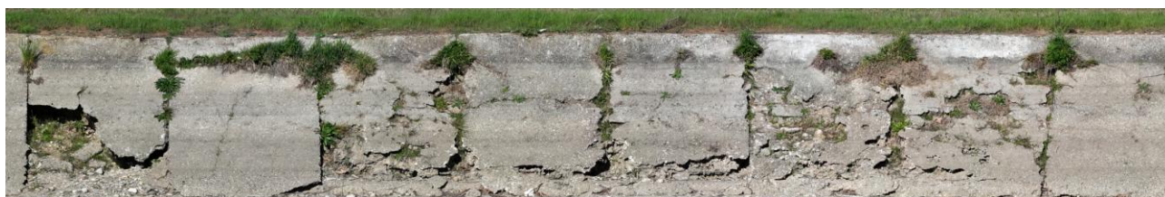
Sponda destra tra le progressive 12+600 e 13+100 – rivestimento inclinato in calcestruzzo
