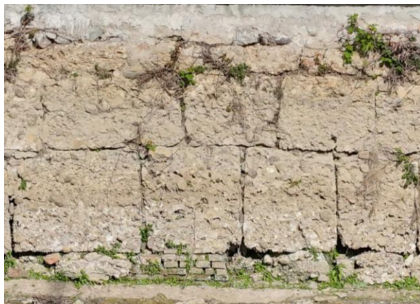
Sponda destra tra le progressive 18+200 e 18+350 – muratura verticale in calcestruzzo e tratto in puddinghe e mattoni
