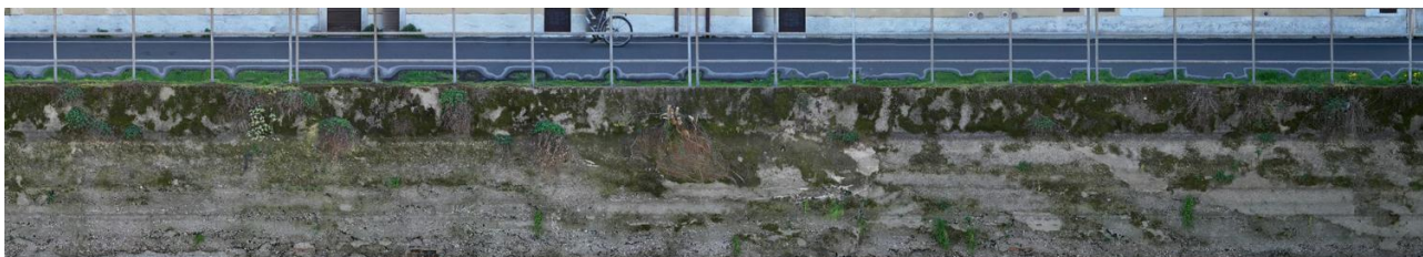
Sponda sinistra tra le progressive 11+400 e 12+500 – muratura verticale in calcestruzzo
